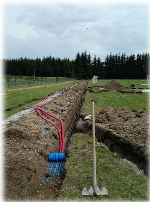
Ce nouveau système permet d'arroser en alternance et par zone la pelouse principale avec 24 buses ainsi que le petit terrain d'entraînement avec 8 buses.
